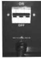
32A D-Kurve Einschalter / Rückstromschalter
