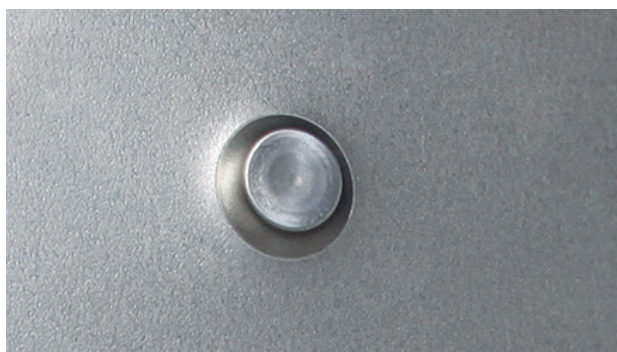
РЕЗУЛЬТАТ УСТАНОВКИ САМОПРОНИКАЮЩЕЙ ЗАКЛЕПКИ
