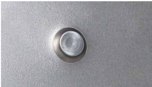
RÉSULTAT DE POSE D'UN RIVET AUTO-PERÇANT
