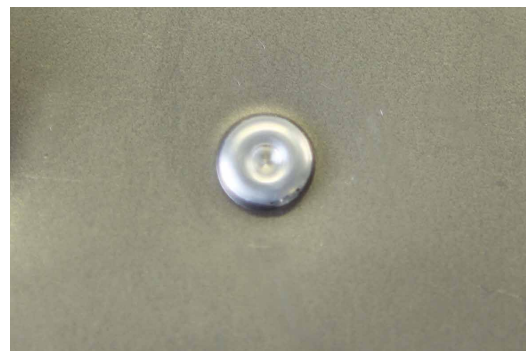
РЕЗУЛЬТАТ УСТАНОВКИ ЗАКЛЕПКИ ТЕКУЩЕЙ ФОРМЫ FLOW-FORM
